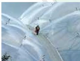
**Gambar 2.105.** Thermoplastik pada Kubah Biome
