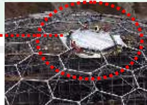
**Gambar 2.106** Pemasangan thermoplastik dan pembersihannya
