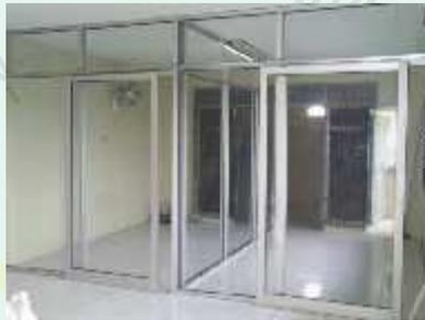
*Gambar 2.34 Pintu dan Kaca Alumunium
