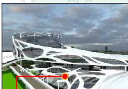
bentuk naungan berupa atap rangka baja dikombinasi dengan kaca temperet untuk mereduksi matahari di area penjemuran body mobil yang selesai di cat.
