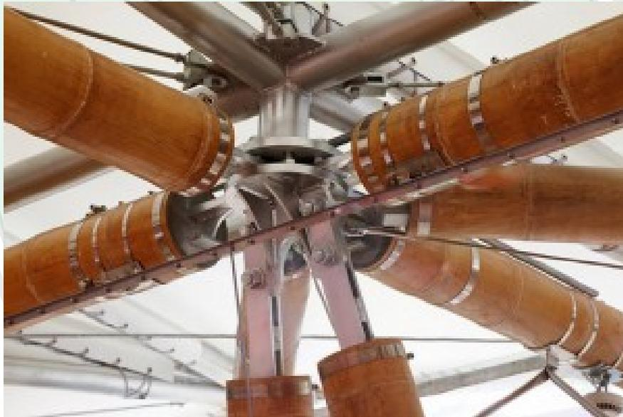
**Gambar 4.60 Sistem rangka pada sambungan bambu**
