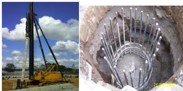
Gambar 2.22 Pondasi bor pile
