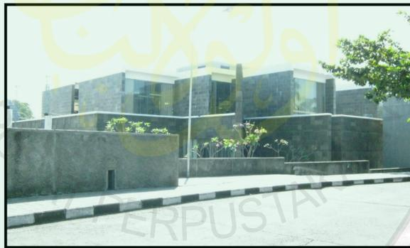
**Gambar 2.62. Pelapisan Batu Padalarang pada Bagian Dinding yang Masif**
