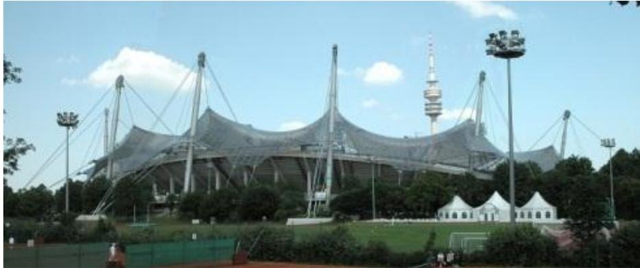
**Gambar 2. 38 Struktur Membran Tenda**
