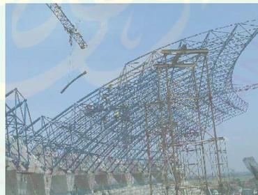
Gambar 2. 16 Struktur rangka ruang sumber: <http://pesonamembrane.blogspot.co.id/2015/10/meningkatnya-permintaan-tenda-membran.html>
