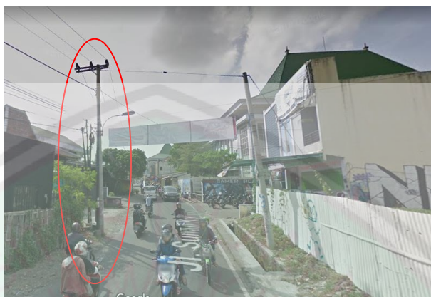
Gambar 4.7 Jaringan listrik jalan Sunan Kalijaga
