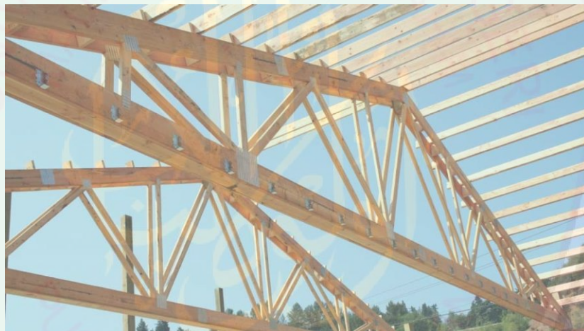
Gambar 4. 40 Struktur Rangka Atap dari kayu Sumber: penulis, 2019
