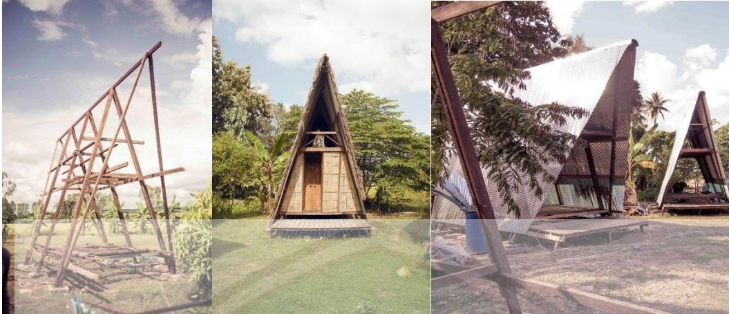
Gambar 2. 27 Rangka atap (kiri), Panel Aluzinc (tengah), Daun Tebu Kering Yang Diaplikasikan pada Atap Bangunan (kanan) Sumber: (www.archdaily.com, 2019)
