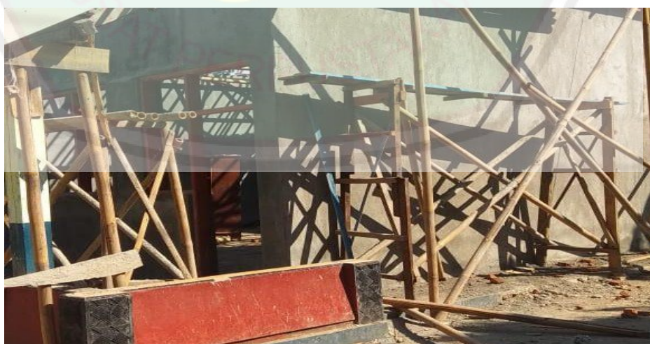
Pembangunan perbaikan ruangan BK di sekolah
