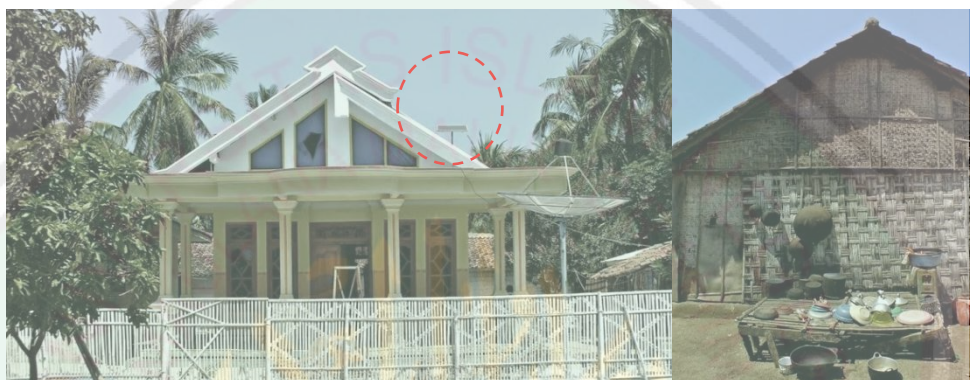
Gambar 4.13. Pembangkit Listrik Tenaga Surya
