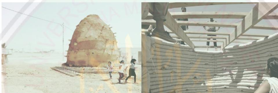
Gambar 2. 23 Metode sak pasir dengan daun bambu
