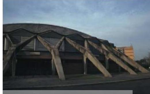
Gambar 2.11 Struktur Cangkang Berbahan Beton
