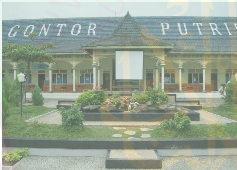
Gambar 2.3 Gedung Perkuliahan Santiniketan PMDG 5
