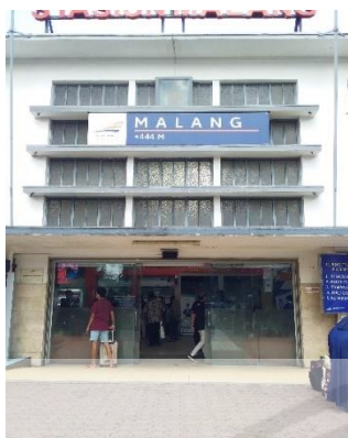
Gambar 2.1 Tampak Depan Stasiun Kereta Api Malang
