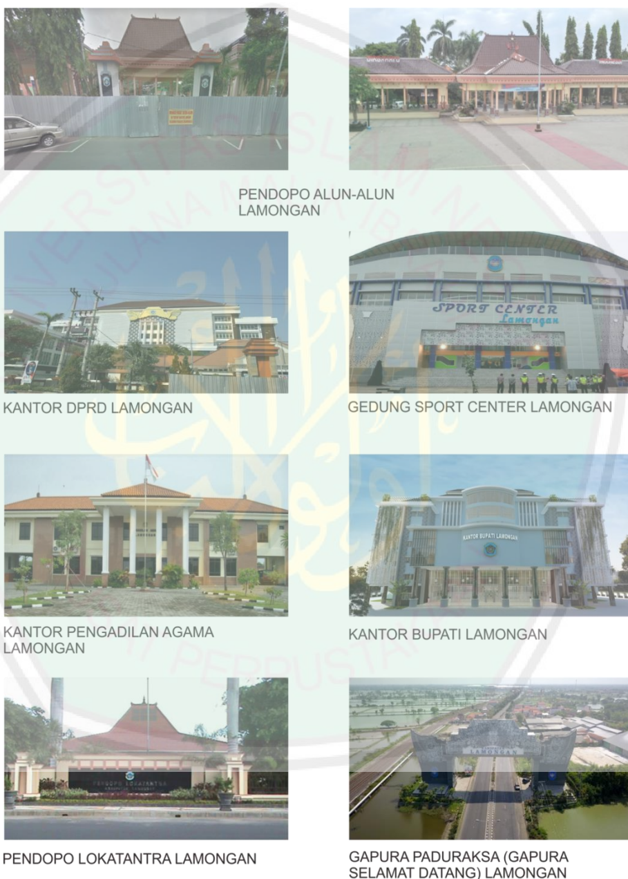
Gambar 5.24 Bangunan Publik di Lamongan Sumber : Dokumen Penulis, 2019
