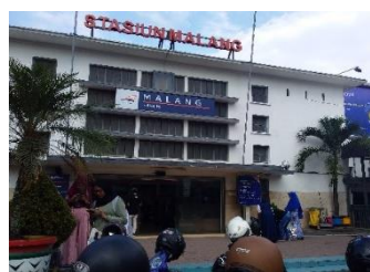
Gambar 2.2 Tampak Depan Stasiun Kereta Api Malang
