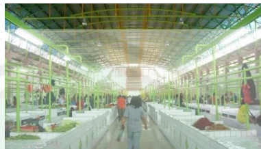
Gambar 2.65 Interior Gedung Sayur Puspa Agro Sidoarjo
