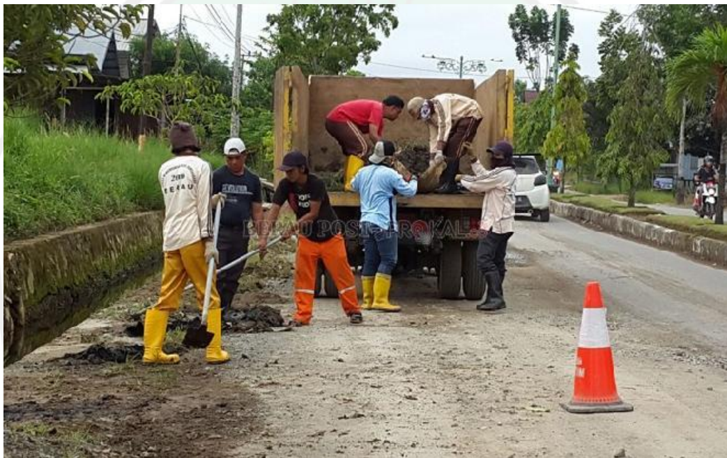
Foto saat Pembersihan Drainase Preservasi Jalan Jolosutro
