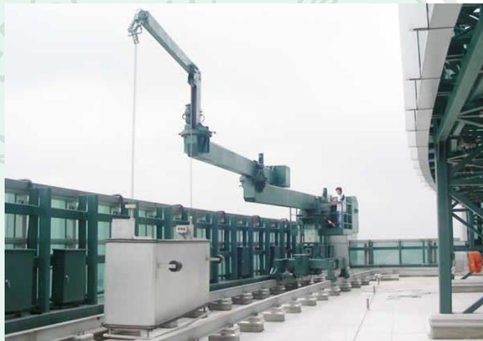
**Fig. 2.1.3.3.34** Gambar Mesin Gondola Alat Pembersih Gedung
