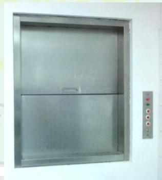
**Fig. 2.1.3.3.30** *Dumb Waiter* Digunakan Untuk *Lift* Makanan
