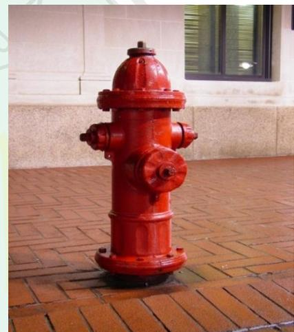
Fig. 2.1.3.3.12 Hidran Kebakaran yang Sering Digunakan di Luar Gedung
