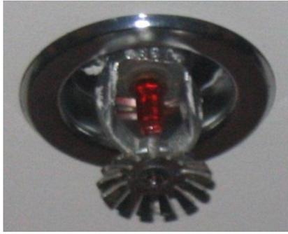
Fig. 2.1.3.3.13 Gambar *Sprinkler Head* Warna Merah
