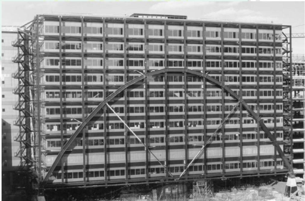
**Fig. 2.1.3.4.2** Struktur Pelengkung
