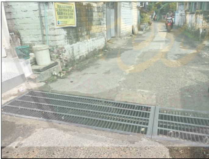
Hasil dari pembangunan (drenase)
