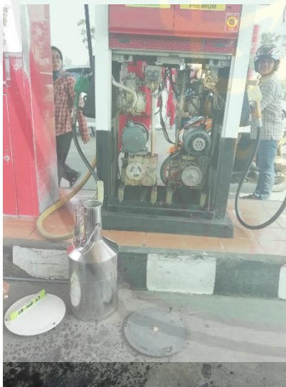
Alat pengukur yang digunakan oleh Dinas Perdagangan untuk mengukur keakuratan takaran BBM di SPBU resmi.
