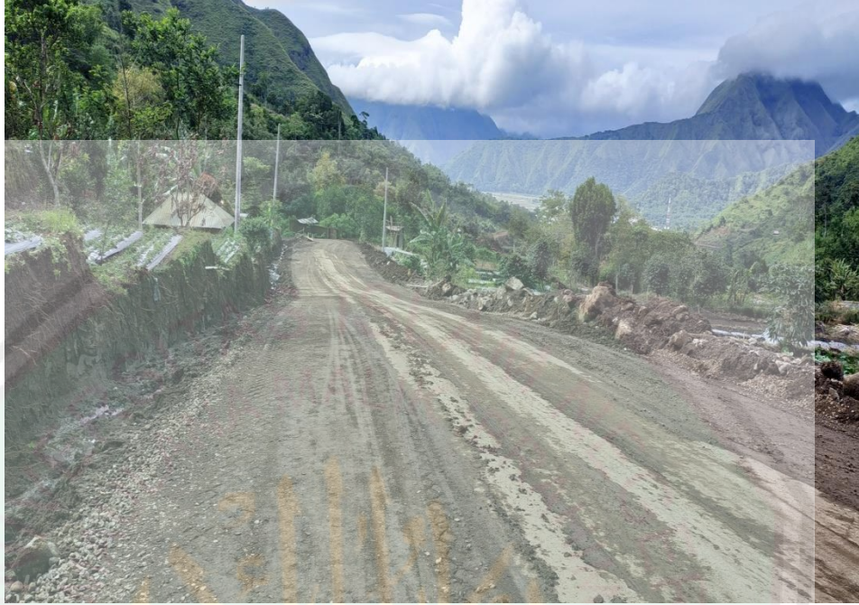
Pelebaran Dan Perbaikan Akses Menuju Sembalun.
