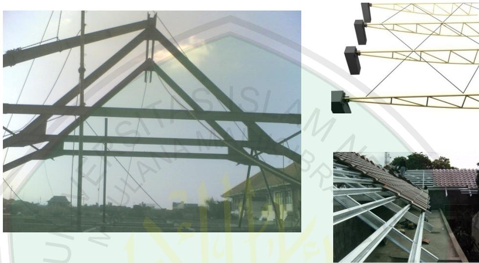
**Gambar 5.53.** Rangka baja dan genteng pada bangunan
