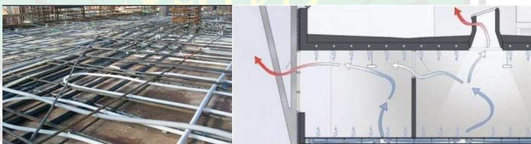
Gambar 2. 35 Sistem Tabung Hidronic
