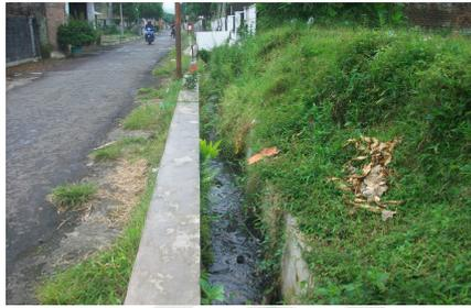
**Gambar 4.5 Sistem Pembuangan Limbah dan Air Hujan**
