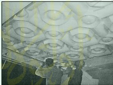
Gambar 2.22 : Plafon dengan permukaan difus dari bahan fiberglass
