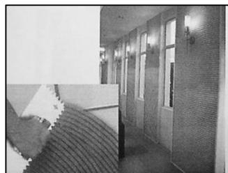
Gambar 2.27 : Dinding bata plester dengan permukaan difus
