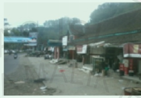
Fasilitas Pertokoan tidak terawat
