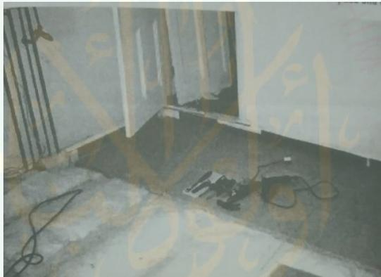
**Gambar 2. 38.raise floor telah diisi selimut dan di tutupdengan papan MDF**
