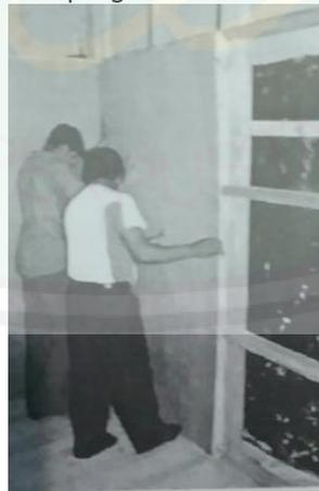
**Gambar 2. 45.pemasangan rangka di lanjutkan pemasangan papan pelepis pada dinding**
