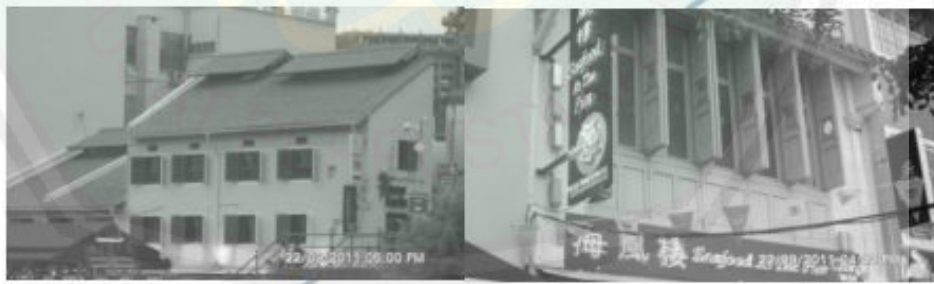
Gambar 2.11 Tampak Bangunan pada Kawasan Boat Quay
