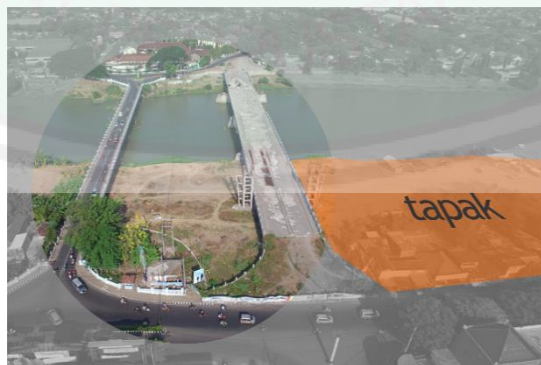
Gambar 5.10 Jembatan Lama dan Jembatan Baru Sumber : Analisis, 2017
