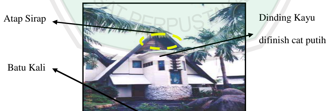
Gambar 2.9 Bangunan Utama (Sri Kurniasih, 2006).
