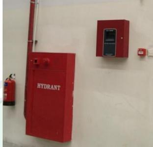
Gambar 4.81 hidran pemasangan dalam
