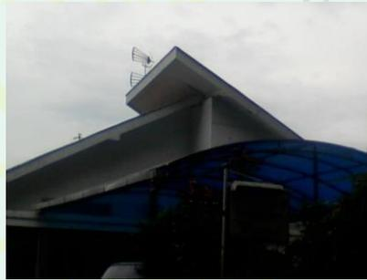
Gambar 4.61 atap pelana pada rumah di jalan Bandung Malang
