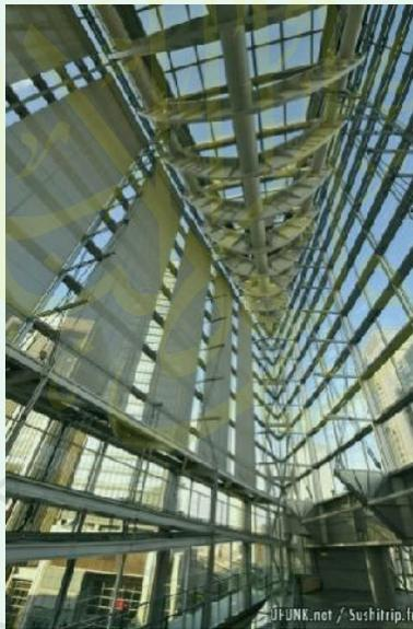
Gambar 2.41. Struktur grid pada kaca
