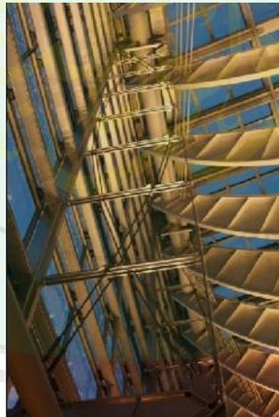
Gambar 2.40. Struktur grid pada kaca
