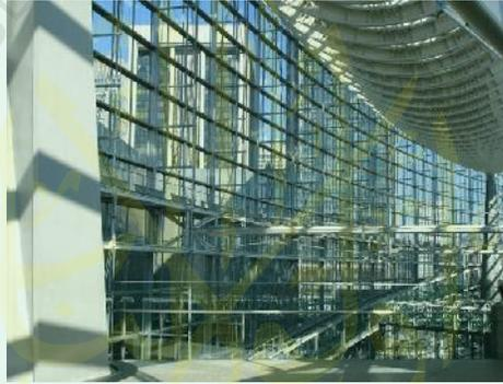
Gambar 2.39. Struktur grid pada kaca
