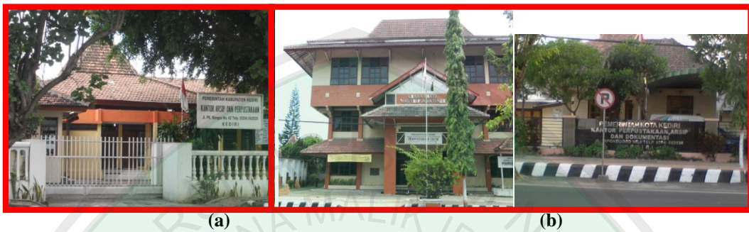
Gambar 1.1 a) Kantor Arsip dan Perpustakaan Kab. Kediri b) Kantor Arsip dan Perpustakaan Kota Kediri (Sumber: Hasil Survey, 2012)
