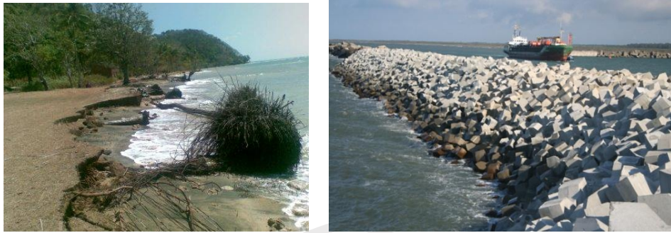
Gambar 4.4 abrasi pantai dan salah satu penanganannya (Sumber: dokumentasi, 2012)
