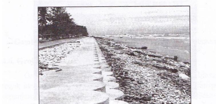
**Gambar 2.24** Dinding pantai dari buis beton
