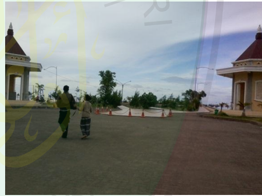
Gambar 2.38 Kondisi pintu masuk menuju ke area Pantai Boom (Sumber: Hasil Survey, 2012)
