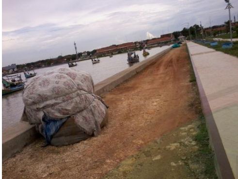
Gambar 2.35 Badan Pantai Boom yang sering difungsikan untuk meletakkan peralatan dari para nelayan sekitar. (Sumber: Hasil Survey, 2012)
