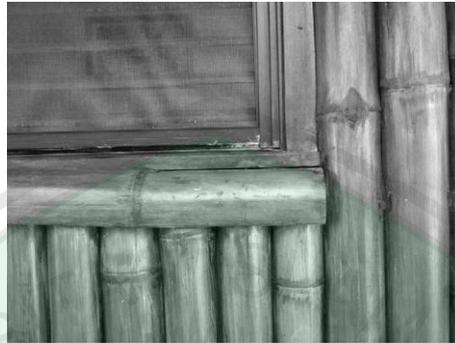
**Gambar 2.40 Detail Bambu Sebagai Dinding**
