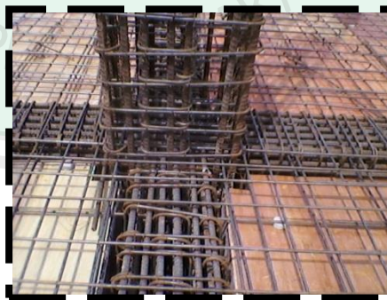
Gambar 4.64. Tulangan Kolom Balok Sumber : Dokumentasi Pribadi
