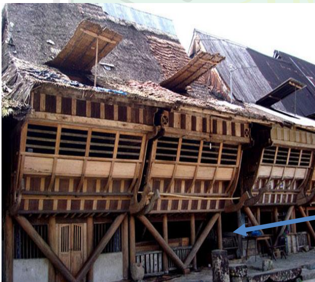
Gambar 2.32. Bagian Kolong pada Rumah Nias http://www.google.com
