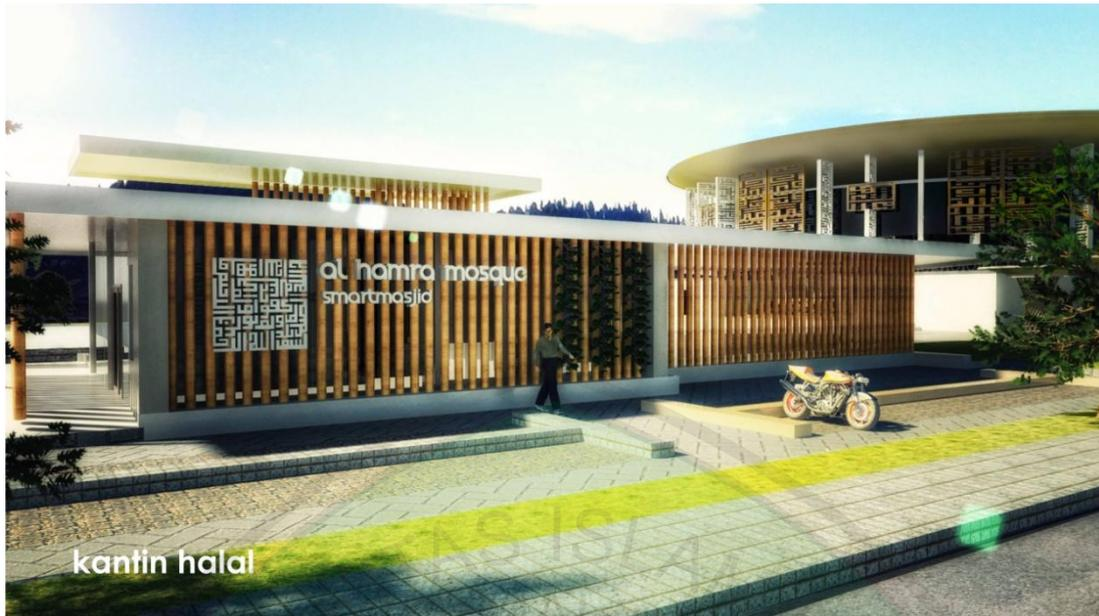
**Gambar 6.23. Pemanfaatan Material Bambu di Area Fasade Kantin**
