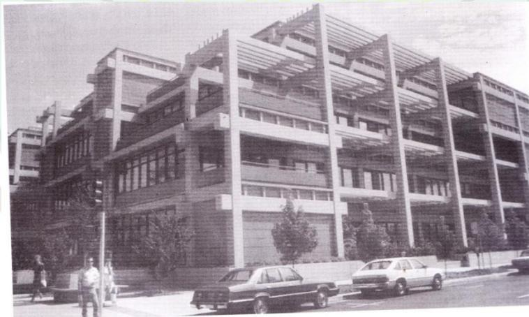
**Gambar 2.44** Setiap fasade yang terdapat di gedung Bateson merupakan sesuatu yang berbeda karena pengaruh matahari pada setiap orientasi gedung juga berbeda. Pada foto yang diambil pada pagi hari ini, perhatikan louver horizontal pada bidang horizontal di fasade sebelah selatan dan kurangnya pencahayaan yang jelas terlihat di fasade sebelah barat. Pada sore hari, naungan eksterior roll down melindungi jendela barat persis seperti halnya
