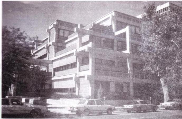
Gambar 2.45 Bandingkan fasade utara dan timur yang tampak dalam foto ini dengan fasade barat dan selatan yang tampak pada Gambar 4.42. Perhatikan bagaimana terlindungnya jendela timur dari sinar matahari pagi.
