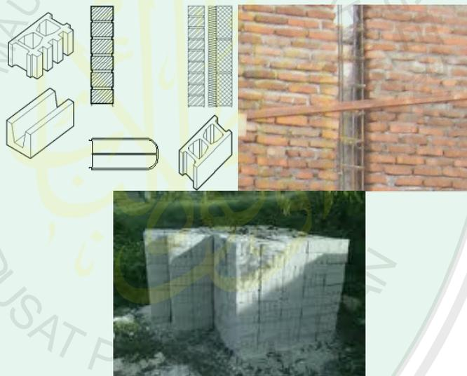
Gambar 5.16 bata berrongga untuk dinding bangunan industri, dan bata putih/merah untuk bangunan penunjang
