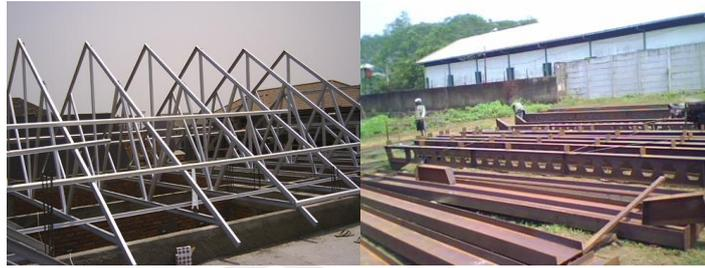
Gambar 5.15 menggunakan struktur baja ringan
