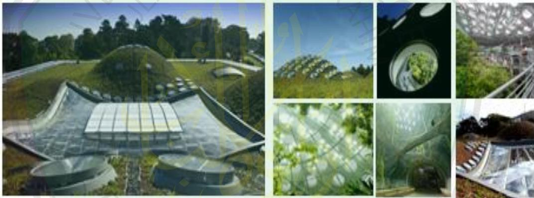
Gambar 2.16 atap hijau kombinasi 55.000 tabung dari multi-kristal sel fotovoltaik
