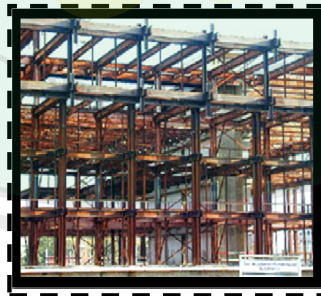
Gambar2.14 Struktur Hi Tech Mall Surabaya Sumber: struktur dan konstruksi, 2008
