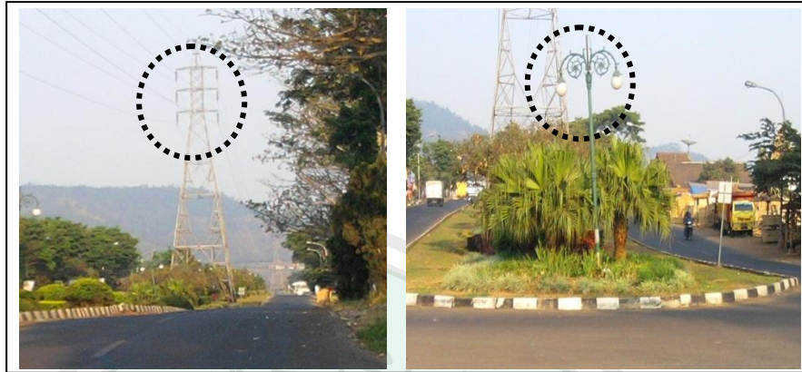
Gambar 4.11 Tower listrik dan lampu di boulevard Sumber : Hasil survey (2013)
