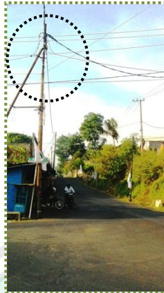
Gambar 4.9 Tiang telepon Sumber : Hasil survey (2013)
