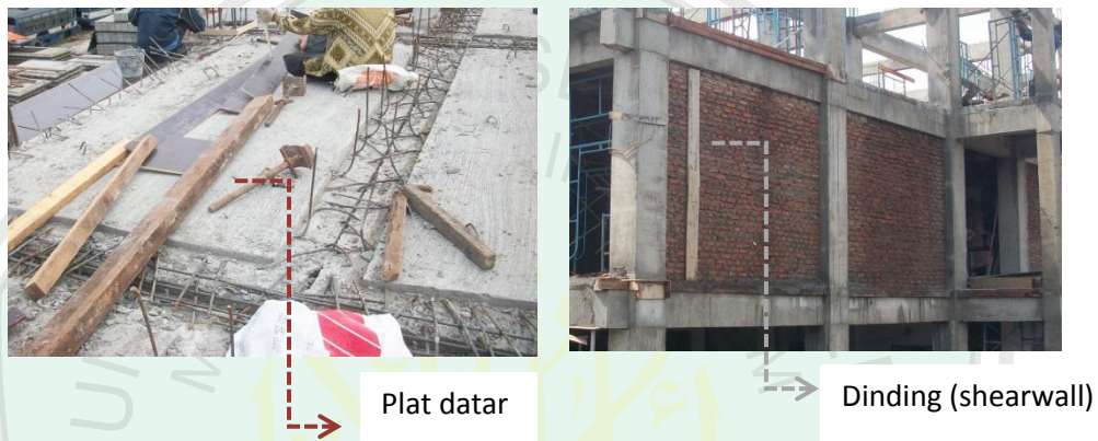
Gambar 4.69 plat datar dan dinding Sumber : Dokumentasi pribadi (2013)
