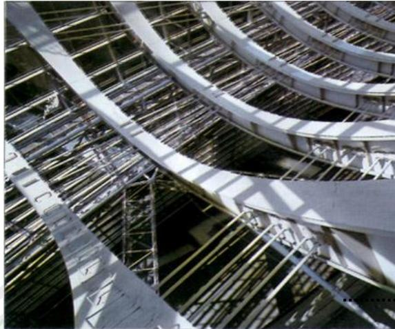
Detail struktur atap baja profil dengan kabel-kabel baja
