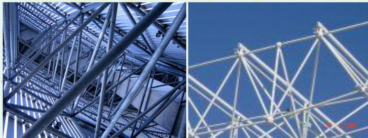
**Gambar 2.44** Struktur Rangka Ruang
