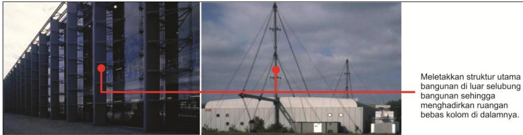
**Gambar 2.73** Struktur yang Diletakkan Diluar
