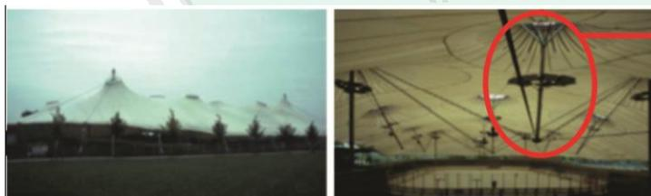
Struktur membran membutuhkan kabel dan tiang penyangga untuk mengantisipasi tiupan angin.
