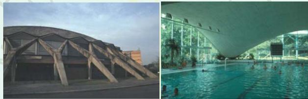
**Gambar 2.58** Struktur Cangkang Berbahan Beton
