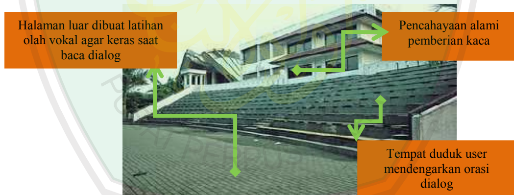
Gambar 2.19 Eksterior dan Ruang Terbuka
