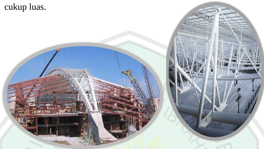
Gambar 4.49. Struktur rangka ruang / space frame
