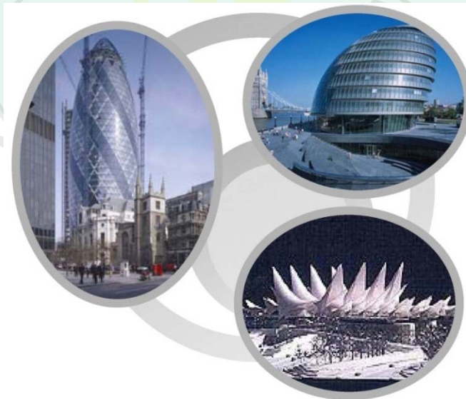
Gambar 4.35. Bangunan-bangunan high tech dengan bentuk futuristik Sumber: www. Fosterandpartners.com
