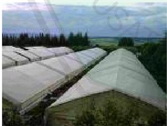
c) Crop top structures (Struktur Puncak Tanaman). Green house pada katagori ini dibuat atap tanpa ada dinding. Atapnya bisa terbuat dari plastik atau kaca, kain (shade cloth), atau ram nyamuk (insect screening). Struktur ini dibuat sedemikian rupa untuk melindungi tanaman dari air hujan atau mengurangi intensitas cahaya.
